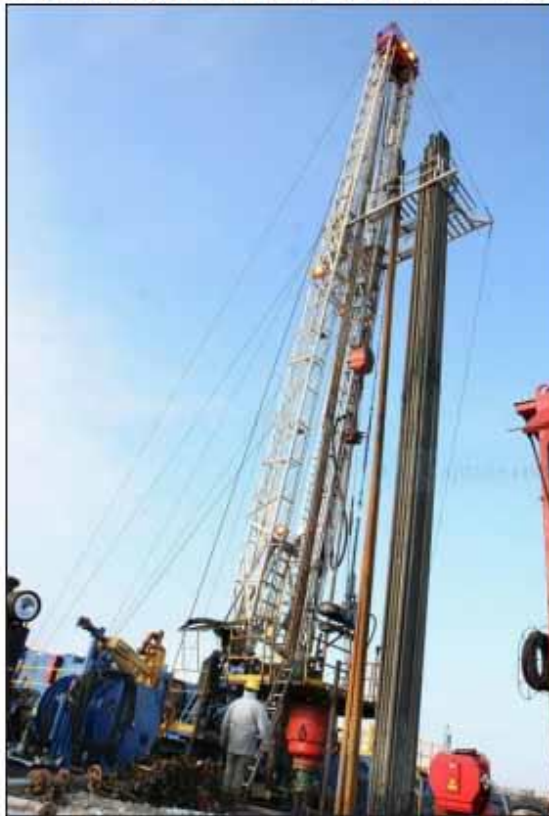
Un exemple de forage d'exploration de gaz de couche. Photo Archives RL.
